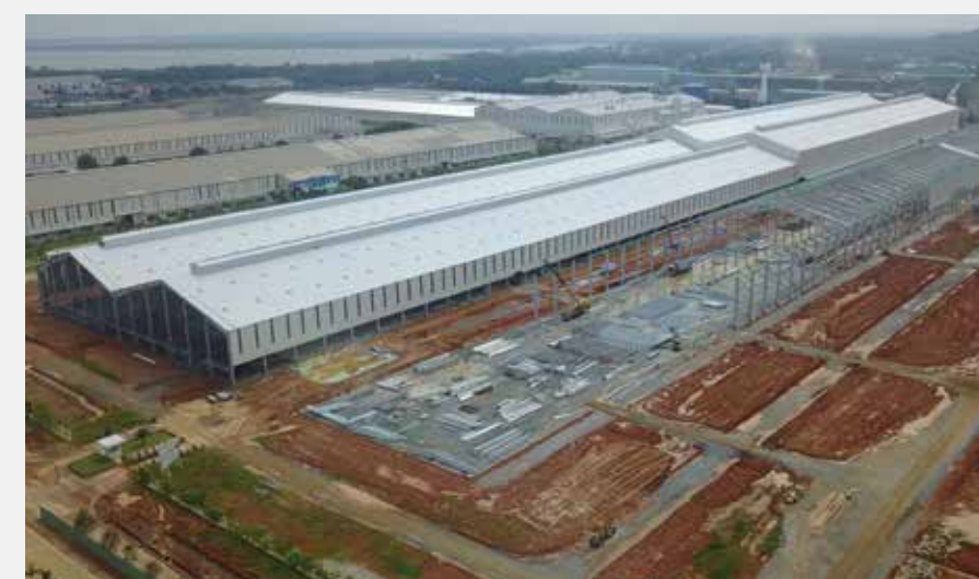
Lắp dựng nhà xưởng Workshop building installation
