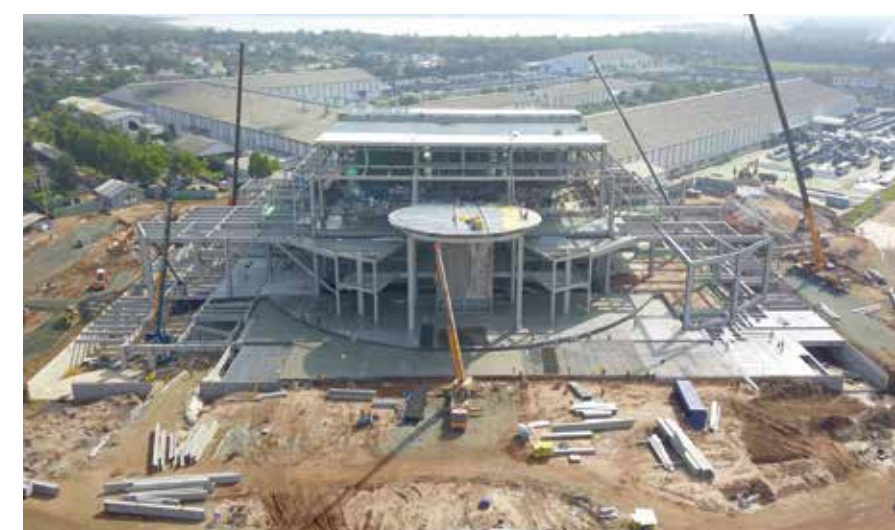
Lắp dựng công trình dân dụng Construction and civil building installation
